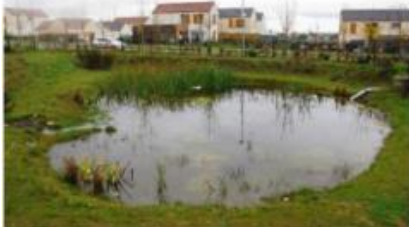
Bassin d'infiltration, lotissement sans réseau pluvial.
