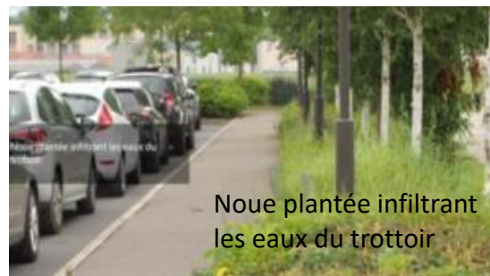
Bordure arasée pour infiltrer l'eau ruisselante
