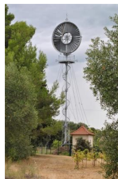
Eolienne Bollée (Quarante)
