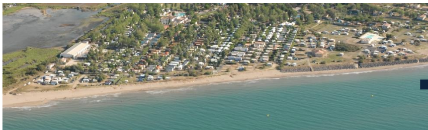
Création d'un nouveau cordon dunaire avec recul des enjeux et suppression d'un enrochement de haut de plage à Vias en 2015
